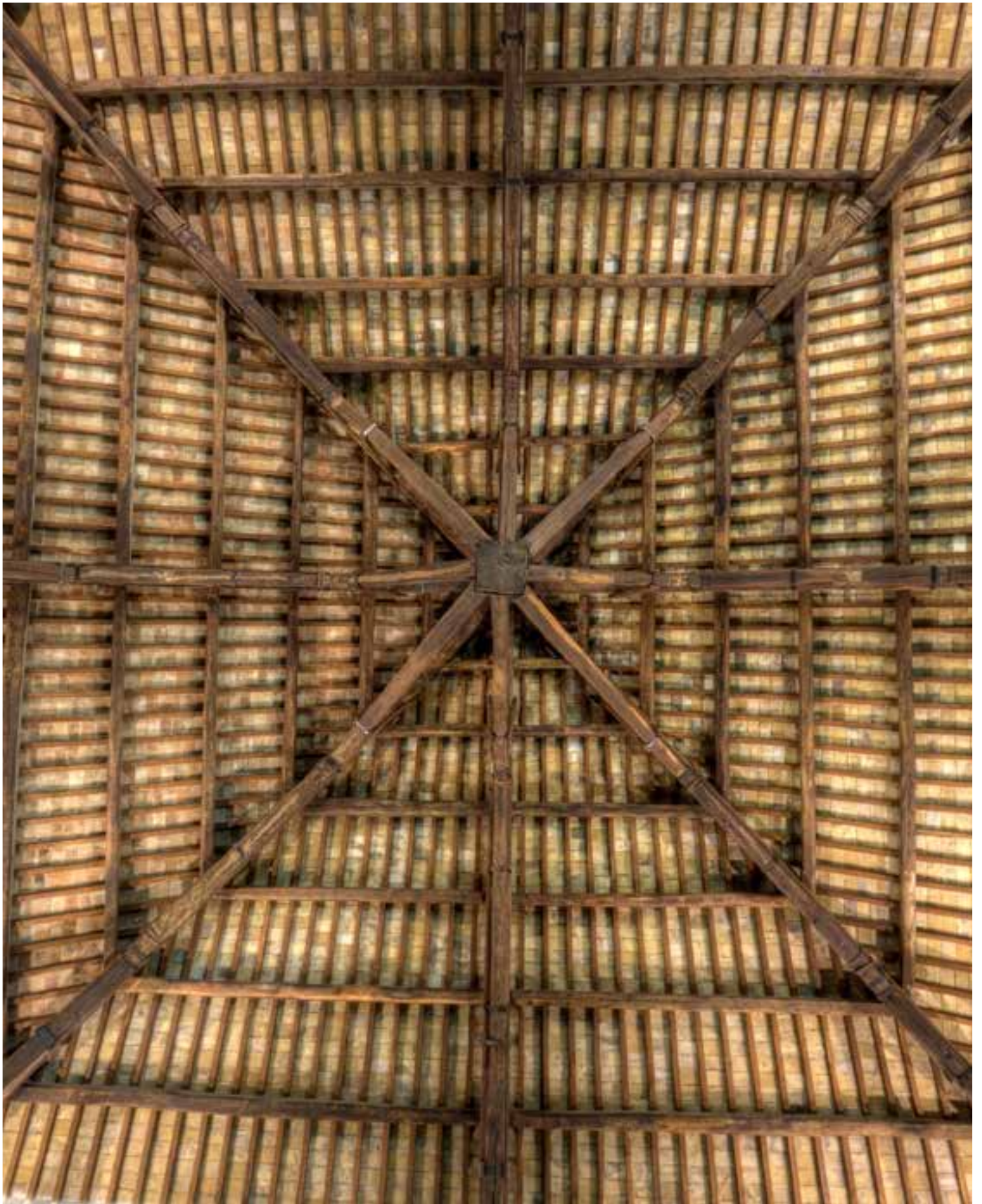
Complesso del San Michele: Sala dello Stenditoio, particolare della grande capriata "a ombrello" che sovrasta la sala, dopo i restauri (foto Archivio Roberto Luciani)
